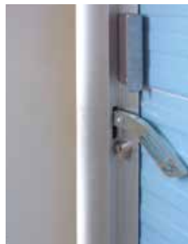
Mit Profilzylinder und geeigneten Griffen, sowie innenliegendem Bedienhebel für Schiebetore.
