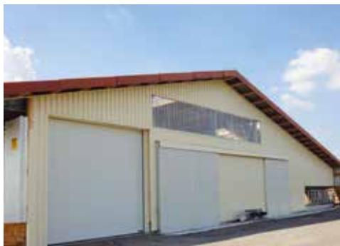
Fassade: „hellelfenbein“, RAL 1015. Schiebetore: „grauweiss“, RAL 9002.
