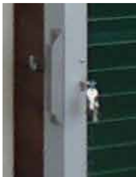
Mit Profilzylinder und geeigneten Griffen, sowie innenliegendem Bedienhebel für Schiebetore.
